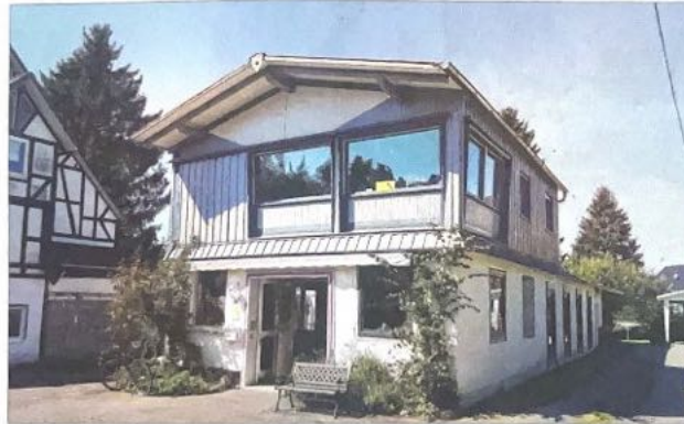
Im Frühling 2024 soll die Baustelle im „Q“ fertig sein.
